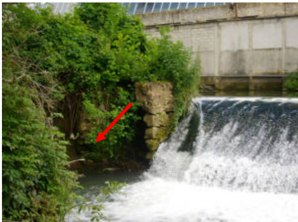
Anse d'érosion importante à combler en rive droite de l'ouvrage de Crevecoeur
