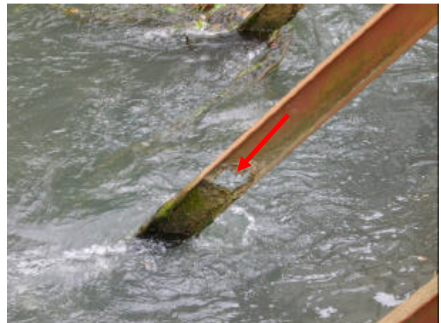
Montant métallique corrodé à remplacer au vannage des Grenouilles à la Ferté Gaucher
