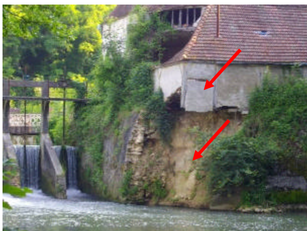
L'effondrement du mur de soutènement et du bâtiment suspendu dans le vide au moulin du Marais nécessite également des travaux d'urgence
