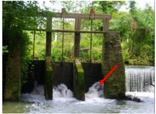
Fuites d'eau entre le contact vanne/montant au vannage de la Verte Vallée
