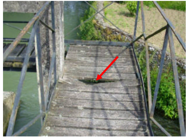
Dégradation de la passerelle d'accès au vannage Communale de Jouy sur Morin à restaurer
