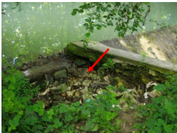
Dégradation de l'ancrage du seuil dans la berge rive droite et voie d'eau importante nécessitent une restauration urgente de l'ouvrage de Montblin
