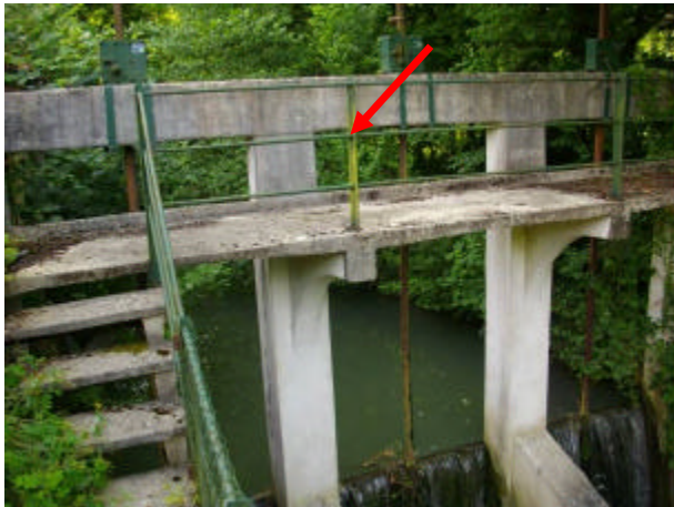
Garde corps au vannage du Marais à sécuriser par la mise en place d'un grillage
