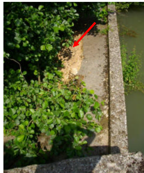
Exemple de dégradation de l'enduit du déversoir du moulin de Court lié au développement important de la végétation ligneuse
